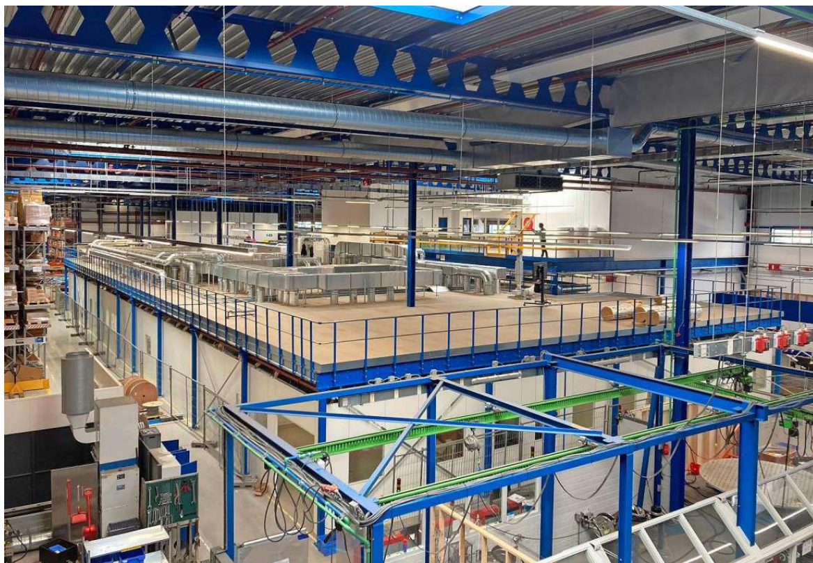
In de grote productiehal van ERIKS in de Boekelermeer is een kleinere hal gebouwd waar de nieuwe cleanroom in komt.
